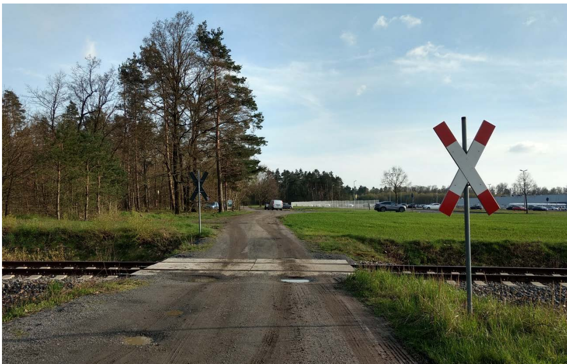
Foto: bestehende Gleisquerung nordöstlich TDDK (IVAS 04/ 2023)
