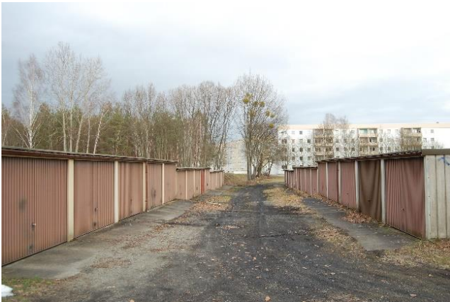
Garagenkomplex Am Wirschk
